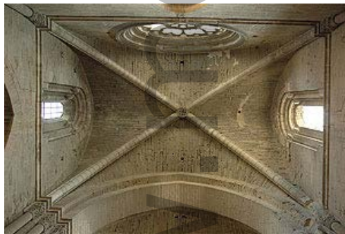
Bóveda de la Seu
