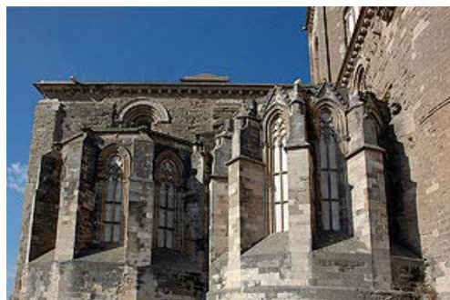
Absidiolos del transepto sur
